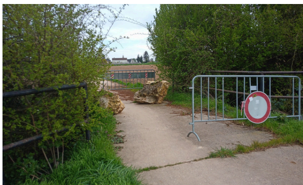
BRÜCKE AM BERGWEG
