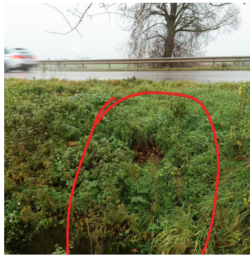
Noch Versiegeltes Durchflussrohr an der B271
