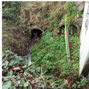
Ungesicherte Abflussrohre
